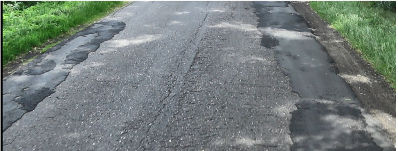
Rys. 2 Stan nawierzchni w km ~0+100 (łaty, spękanie podłużne, ubytki)
