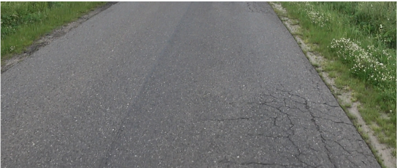
Rys. 6 Stan nawierzchni w km ~2+500 (łaty, pęknięcia krawędziowe siatkowe)
