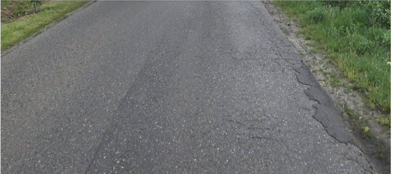
Rys. 5 Stan nawierzchni w km ~2+100 (łaty, pęknięcia krawędziowe siatkowe)
