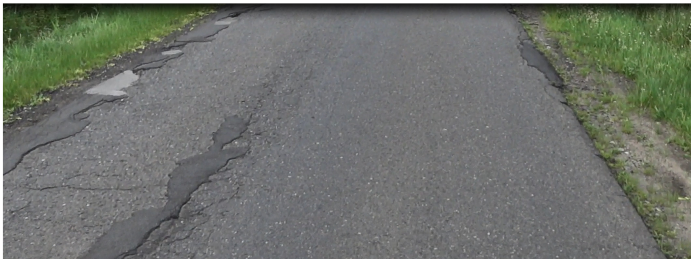
Rys. 7 Stan nawierzchni w istniejącym km ~2+400 (łaty, spękania siatkowe, pęknięcia krawędziowe)
