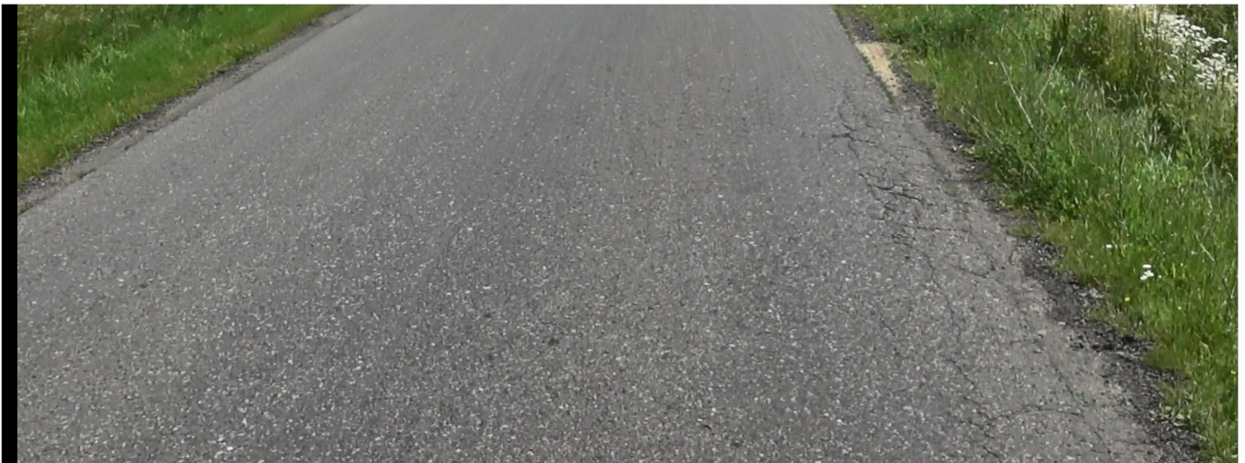
Rys. 3 Stan nawierzchni w km ~0+700 (pęknięcia krawędziowe siatkowe)
